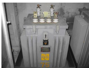
高圧変圧器（トランス）
