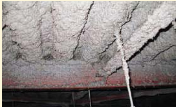
事務室の天井裏
