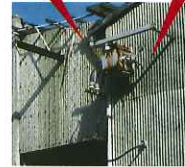
高圧変圧器 高圧コンデンサー
