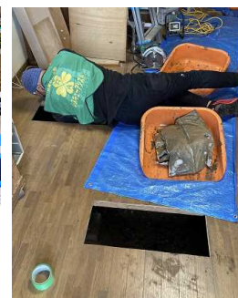
令和4年台風第15号災害時の作業（磐田市）
